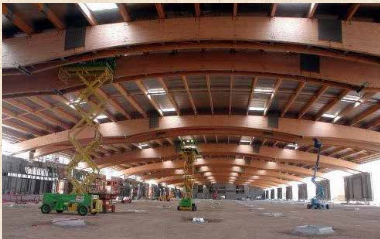
2001 Brescia Costruzione Nuova Fiera.
