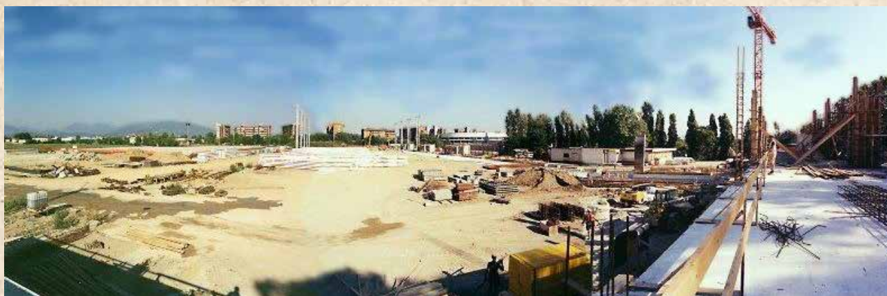
1999 Brescia Costruzione Nuova Fiera.
