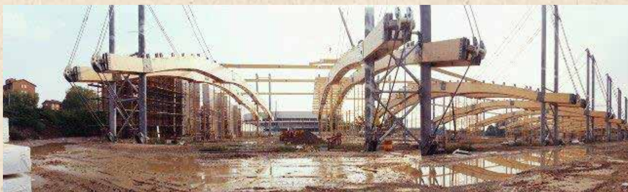
2000 Brescia Costruzione Nuova Fiera.
